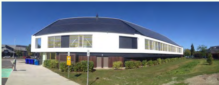
Bibliothèque de Varennes Varennes (110 kW)
