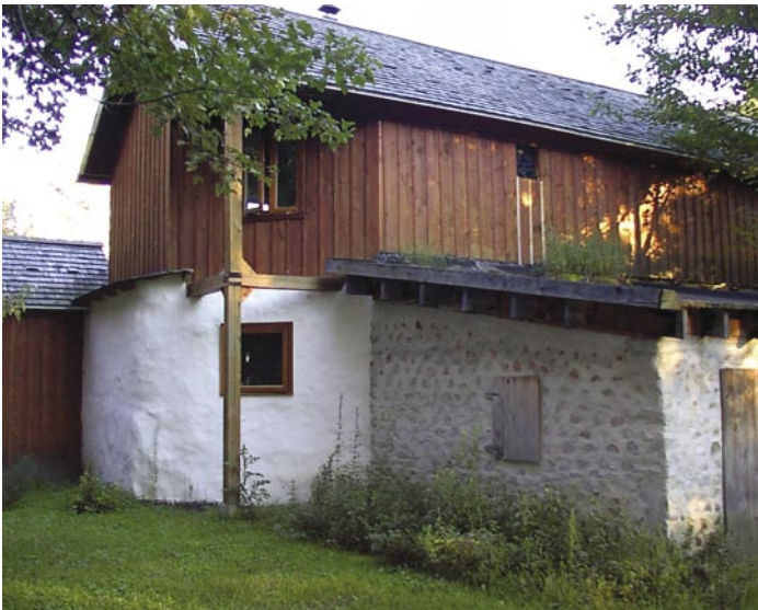
Pour la rendre plus étanche à l'air, Jean-Pierre Charrette, de Lavaltrie, a choisi de recouvrir l'extérieur de sa maison d'un crépi, à l'exception du cavot.
