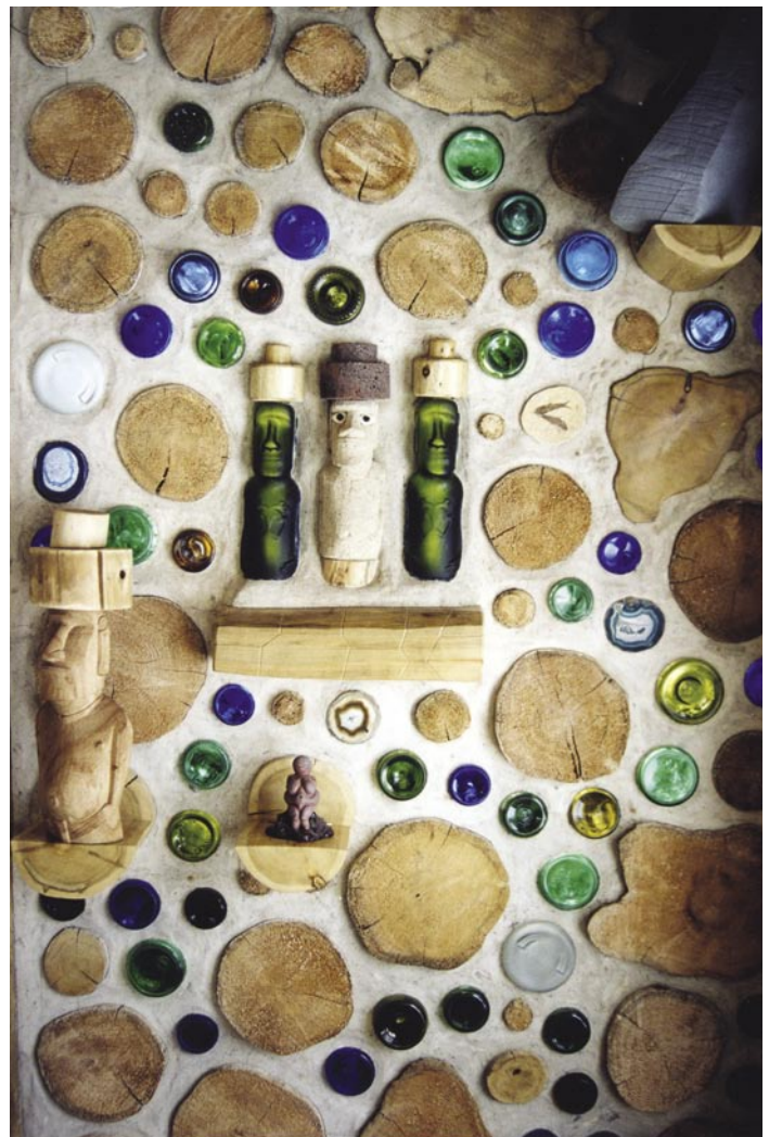
Certains feront aussi sortir des bûches des murs pour créer tablettes, supports et escaliers ou encore y inclure des ajouts décoratifs.
