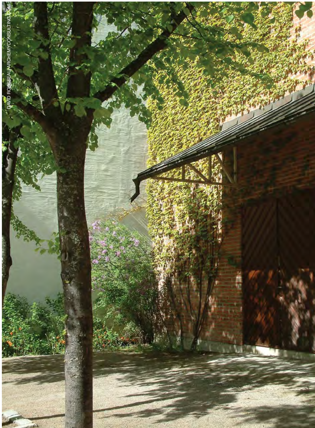
Les vignes empêchent les rayons du soleil de réfléchir vers le jardin et de stocker leur chaleur dans les murs. Il faut éviter de les implanter sur des murs en mauvais état et les tailler lorsqu'elles sont à maturité.
