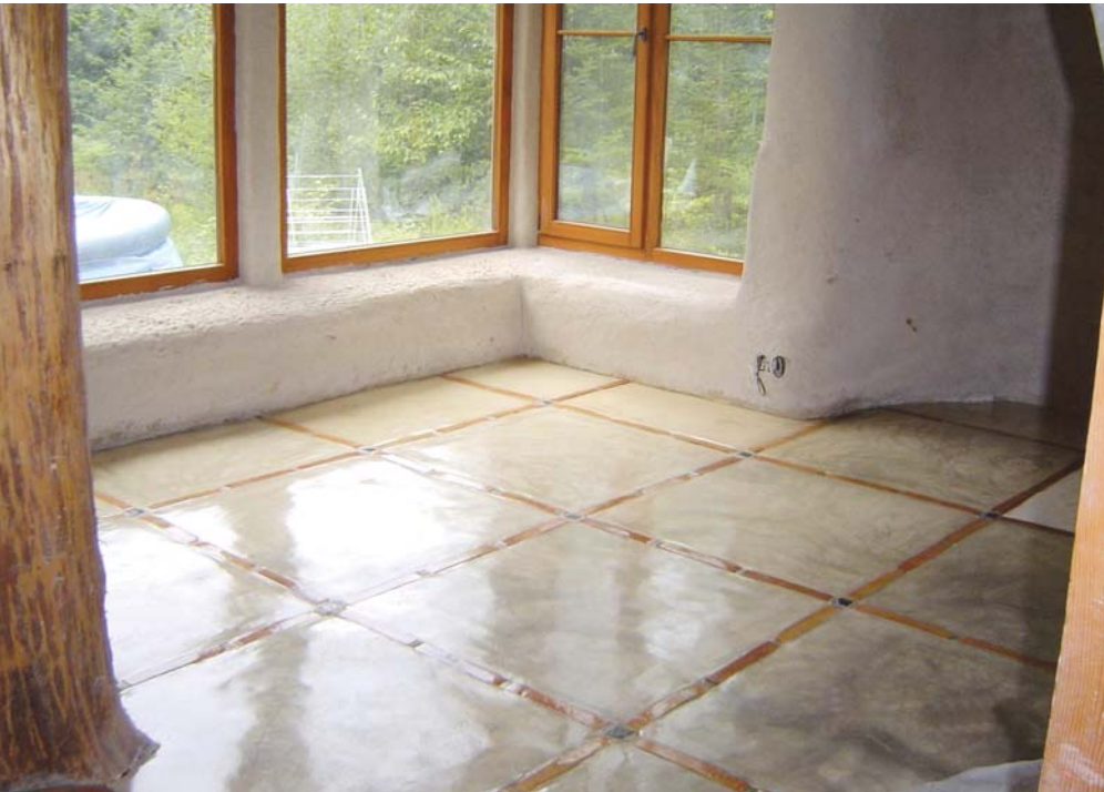
Plancher d'argile stabilisé au ciment avec insertions en terre cuite, à Ste-Catherine-de-Hatley.
