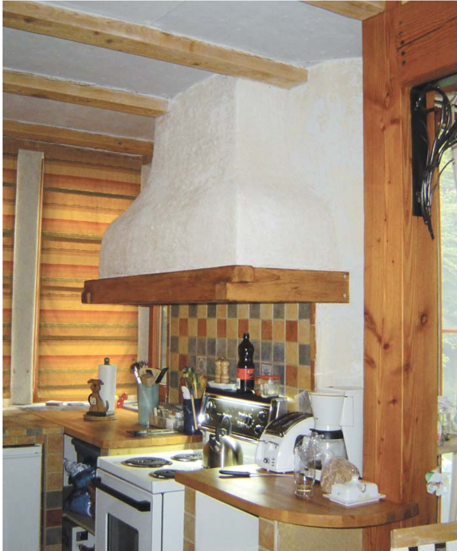
Hotte de cuisine en enduit d'argile avant finition, Ste-Catherine-de-Hatley. Remarquez l'élegance d'un agencement d'argile et de tuiles de céramique.
