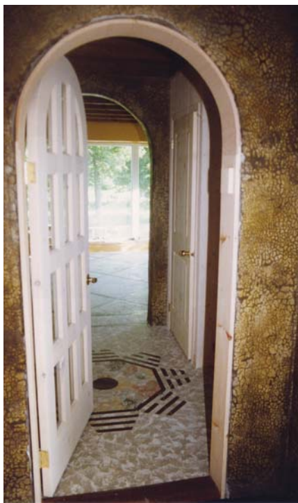
Maison terre-paille conçue et construite par Donald Thériault de Cogepco Immobilier, à Saint-Étienne-de-Lauzon. Remarquez les murs et planchers en argile massive.
