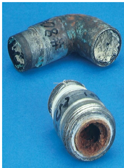
Tuyaux remplis de calcaire et de fer.
