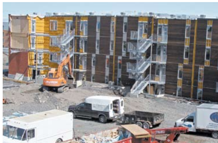
La structure des toitures a été renforcée afin de pouvoir éventuellement y installer des panneaux solaires.
