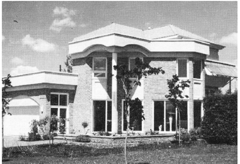
La Maison performante de l'APCHQ
