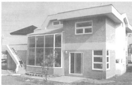
La Maison Nortec (Sainte-Dorothée-de-Laval): Murs R-32 de 8 pouces d'épaisseur, en colombages de 2" x 4", fibre de verre recyclé, contreplaqué en sandwich entre deux épaisseurs de polystyrène extrudé. Toiture 1/2". Une
