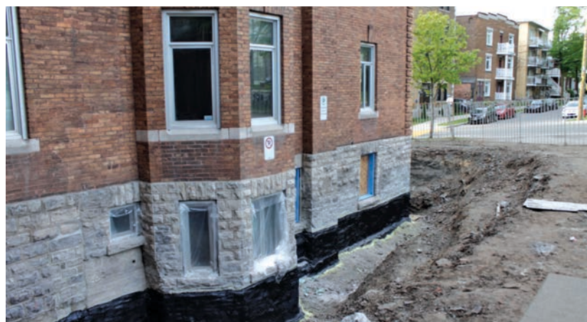
Figure 5.4 Travaux d'étanchéité des murs de fondation
