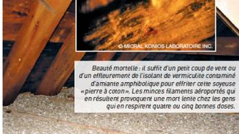
Beauté mortelle : il suffit d'un petit coup de vent ou d'un effleurlement de l'isolant de vermiculite contaminé d'amiante amphibole pour élever cette soyeuse « pierre à coton ». Les minces filaments aéroportés qui en résultent provoquent une mort lente chez les gens qui en respirent quatre ou cinq bonnes doses.
