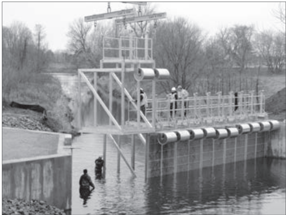
Construction du barrage de lamproies à Notre-Dame-de-Stanbridge.
