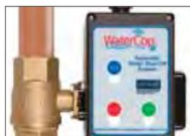
ce panneau permet d'ouvrir et de fermer le robinet principal sans devoir descendre au sous-sol. Lors de l'armement du système de sécurité, le nouveau robinet interactif *Zwave* se ferme automatiquement,
