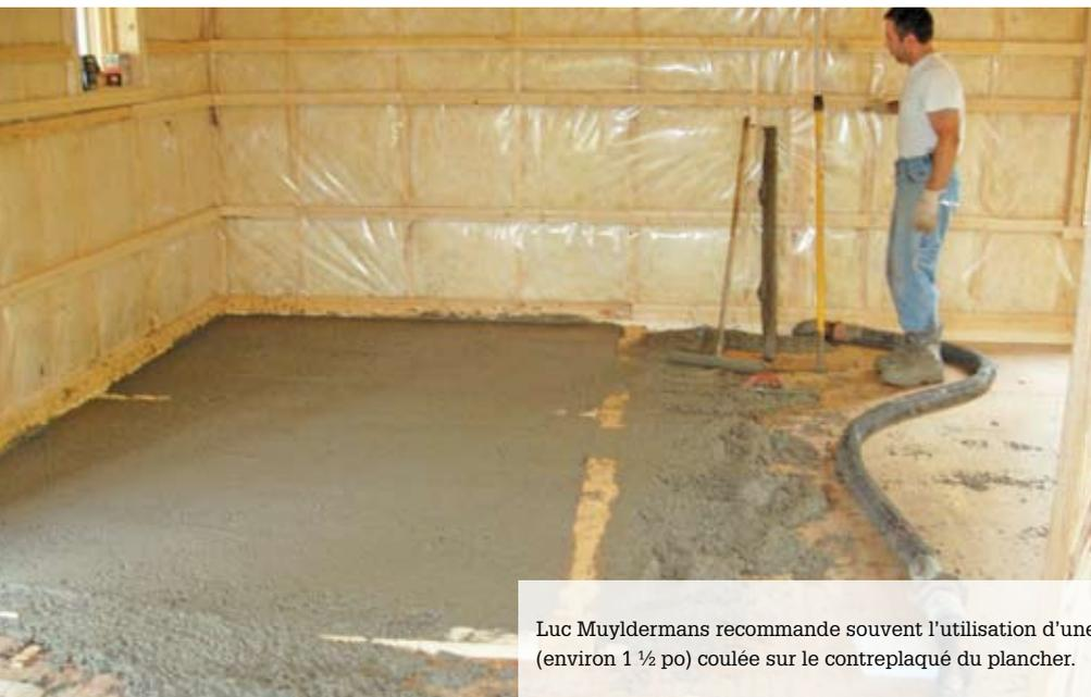
Luc Muyltermans recommande souvent l'utilisation d'une mince dalle de béton de 32 à 35 mm (environ 1 ½ po) coulée sur le contreplaqué du plancher.
