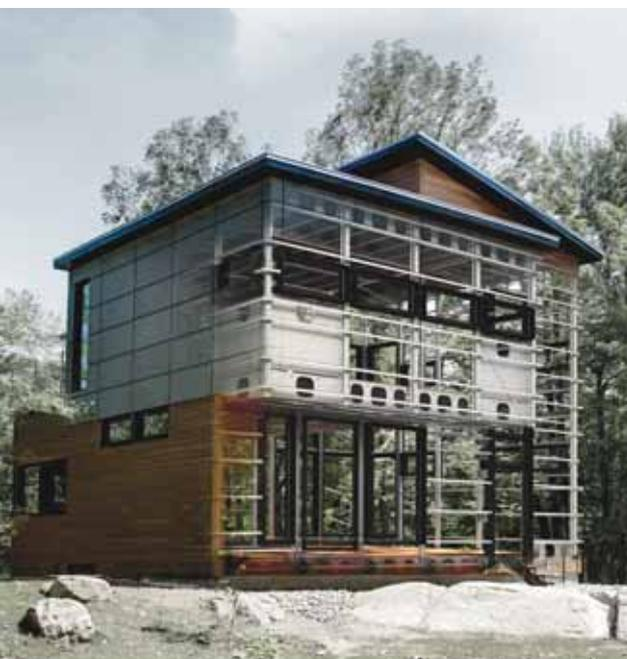
Il suffit d'une semaine pour assembler la coquille au complet sur ses fondations et de quelques jours supplémentaires pour la fermer de façon étanche avec ses portes et fenêtres.
