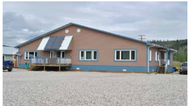
Figure 1 Maison durable E/9 construite pour le Nord (logement solaire à gauche, logement Bâti-Flex à droite)
