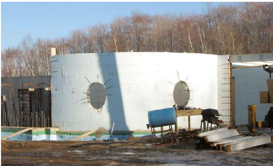
Le coffrage isolant se prête très bien à la construction de murs courbés.
