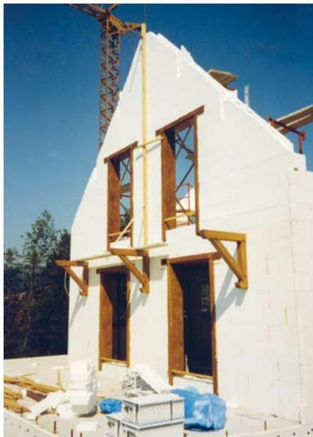
**Les coffrages isolants offrent plusieurs avantages : résistance supérieure au passage de la chaleur et du son, au vent, au feu, à l'humidité et aux insectes, et stabilité à long terme. Toutefois, il est sage d'embaucher des installateurs expérimentés pour s'assurer de la qualité de l'assemblage.**
