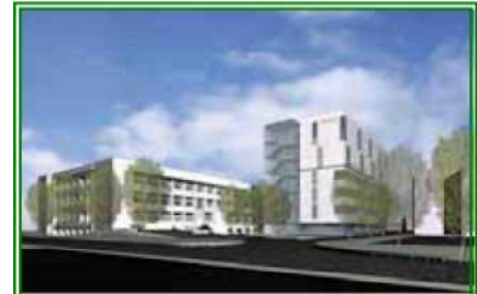
Bâtiment ICIC, Université de la Colombie-Britannique Vancouver
