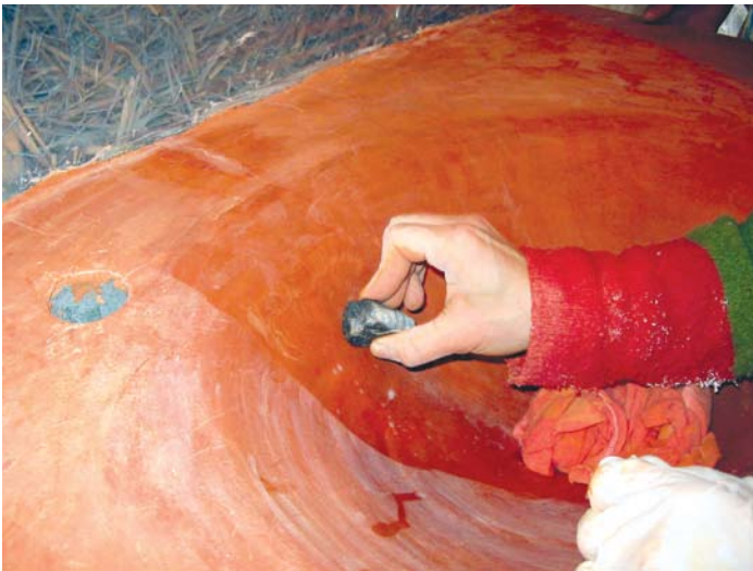
Le polissage du tadelakt au galet permet d'imbiber la surface de savon noir et d'en assurer l'imperméabilité.
