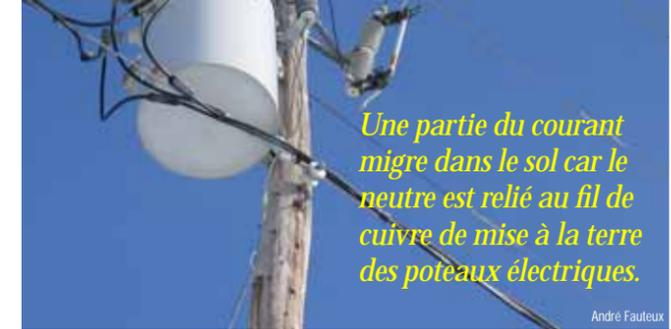
Une partie du courant migre dans le sol car le neutre est relié au fil de cuivre de mise à la terre des poteaux électriques.
