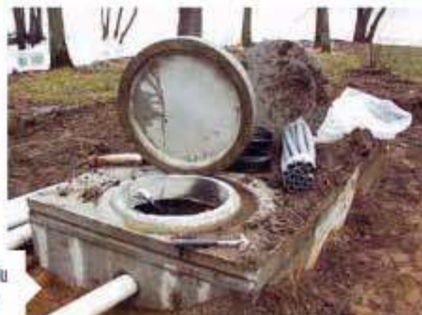
L'installation du puits artésien
