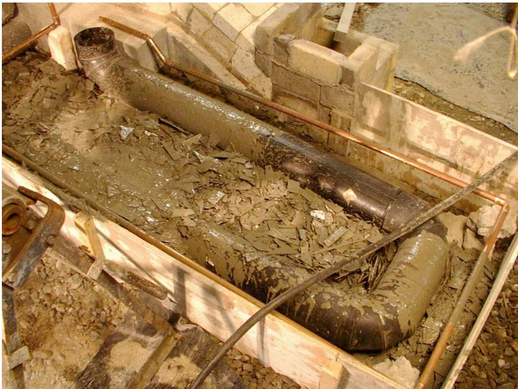
On recouvre le tout d'une double épaisseur de carton avant de construire le coffrage pour le revêtement extérieur en béton de verre concassé. Le carton va brûler aux premiers feux et laisser un interstice de 3 à 5 mm (environ  $\frac{1}{4}$  po), ce qui constitue un espace suffisant pour recevoir la dilatation causée par la chaleur.
