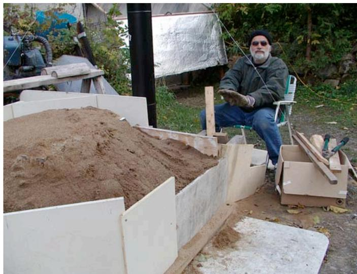
Cette photo a été prise 24 heures après la dernière attisée faite à l'extérieur. Le noyau est encore à 40 °C (104 °F) malgré une nuit froide. Et, surprise, je suis alors étonné de constater qu'il n'y a aucune trace de combustion à l'intérieur malgré la mauvaise qualité du bois utilisé pour les essais et l'humidité de l'ensemble des composantes.
