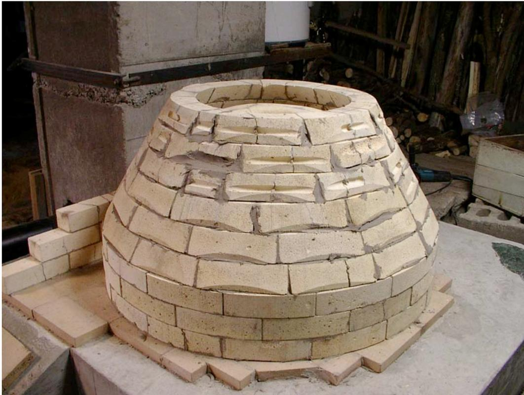
Vue du dessus montrant les arêtes de l'échappement et du cône central, arrondies pour permettre un écoulement laminaire des gaz de combustion. Le tout sera recouvert de plaques réfractaires.
