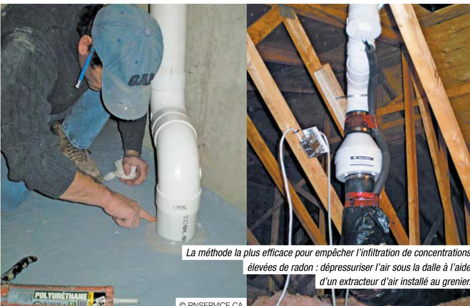
La méthode la plus efficace pour empêcher l'infiltration de concentrations élevées de radon : dépressuriser l'air sous la dalle à l'aide d'un extracteur d'air installé au grenier.
