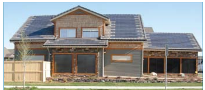
Figure 1 Façade de la maison Avalon Discovery 3 donnant sur le sud
