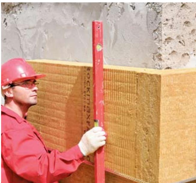
La laine de roche en panneaux est un choix écologique recommandé par EBN. Elle est couramment utilisée en Europe pour isoler l'extérieur des murs et fondations et même sous la dalle de béton. Le fabricant canadien Roxul songe à recommander ses produits commerciaux pour accomplir ces deux fonctions dans les résidences.
