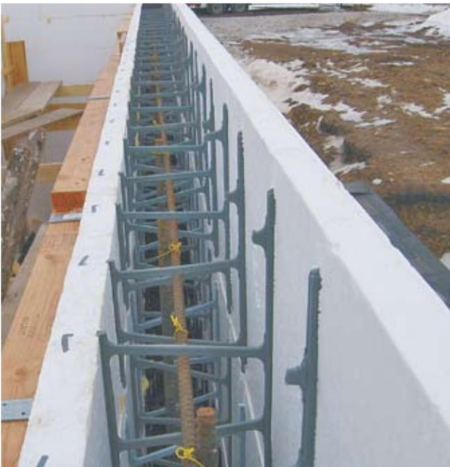
*BuildingGreen.com recommande encore les murs haute performance en polystyrène expansé, dont ceux en coffrages isolants (ci-haut). Toutefois, l'entreprise du Vermont menace de les retirer de son répertoire GreenSpec si les fabricants ne remplacent pas leur retardateur de flamme par un produit moins toxique.*
