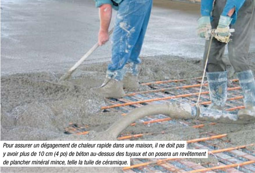
Pour assurer un dégagement de chaleur rapide dans une maison, il ne doit pas y avoir plus de 10 cm (4 po) de béton au-dessus des tuyaux et on posera un revêtement de plancher minéral mince, telle la tuile de céramique.
