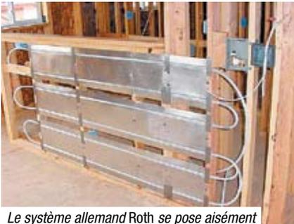
Le système allemand Roth se pose aisément dans les murs ou dans des espaces restreints.
