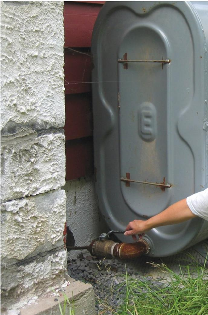
**Le mazout a été livré même s'il n'y avait pas de valve sur le réservoir. Quand la fournaise a rendu l'âme, elle s'est remplie d'huile à chauffage puis a débordé. Un malheur qui aurait pu être prévenu par du professionnalisme.**
