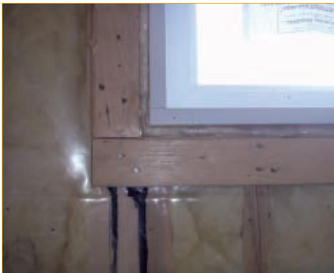
Le système pare-air doit être continu et scellé aux cadres des portes et des fenêtres afin de permettre à l'enveloppe de résister aux infiltrations d'eau et d'air et d'offrir ainsi la meilleure performance possible au plan énergétique.
