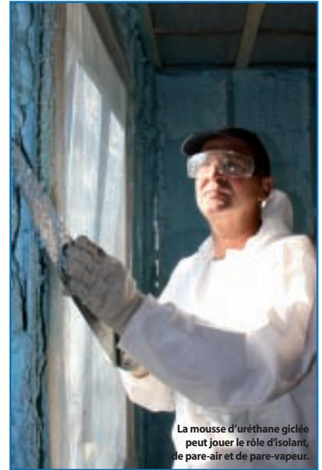
La mousse d'uréthane giclée peut jouer le rôle d'isolant, de pare-air et de pare-vapeur.
