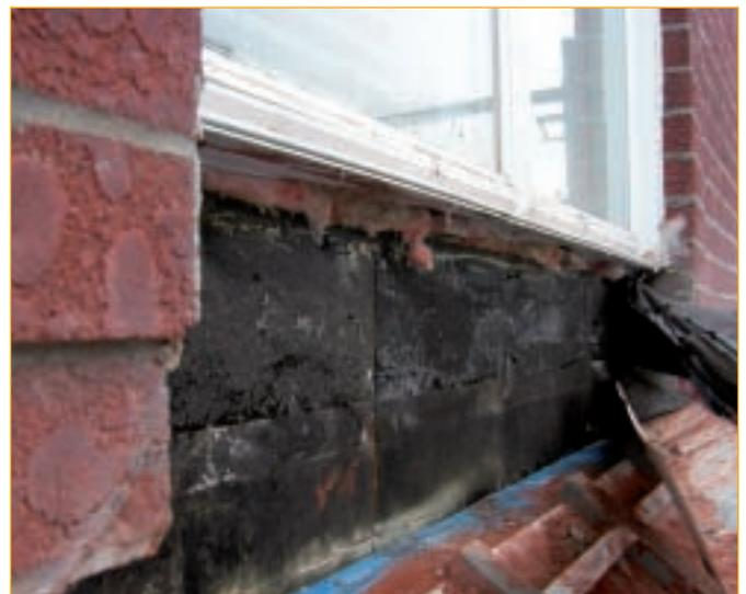
Les solins mis en place à la partie supérieure et inférieure des ouvertures doivent être installés adéquatement de façon à permettre l'écoulement de l'eau à l'extérieur du revêtement.
