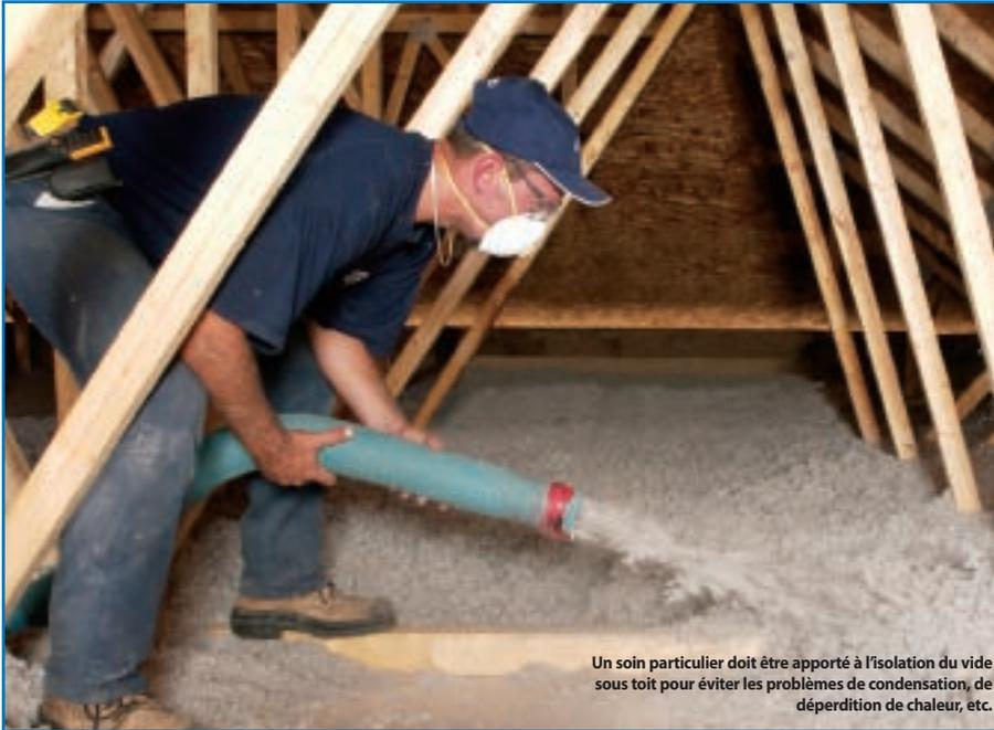
Un soin particulier doit être apporté à l'isolation du vide sous toit pour éviter les problèmes de condensation, de déperdition de chaleur, etc.
