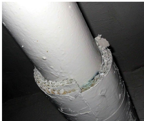
Tuyaux isolés à l'amiante.
