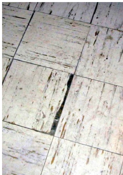
La tuile vinyle amiante peut aussi libérer des fibres dangereuses en se cassant.
