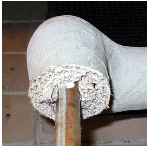
Tuyaux isolés à l'amiante.
