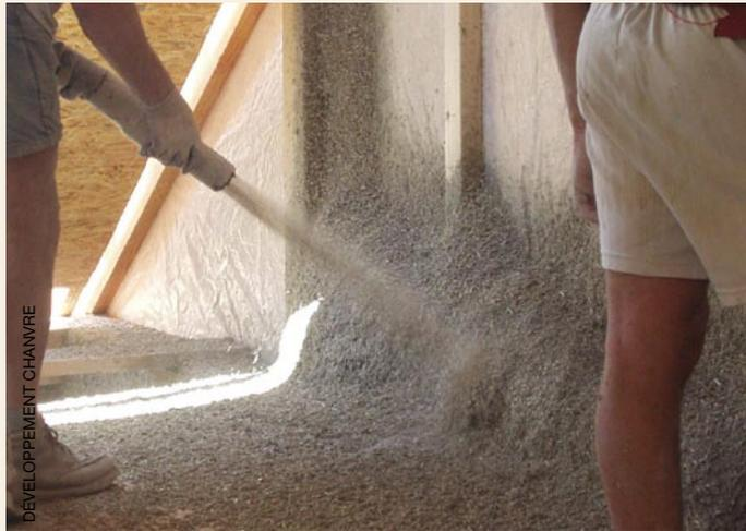
Ce nouvel appareil français permet d'utiliser 60 % moins d'eau dans le béton de chanvre.
