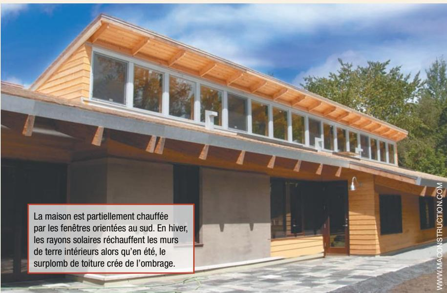
La maison est partiellement chauffée par les fenêtres orientées au sud. En hiver, les rayons solaires réchauffent les murs de terre intérieurs alors qu'en été, le surplomb de toiture crée de l'ombrage.
