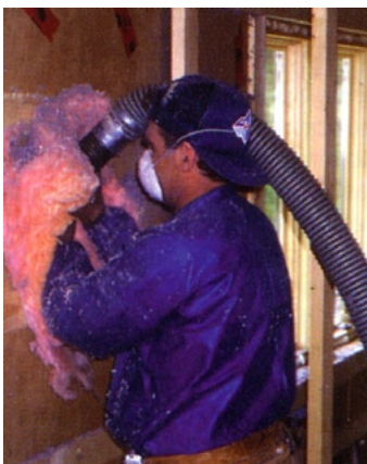
La laine de verre est utilisée pour empêcher que la cellulose injectée à haute pression ne soit éjectée du mur.
