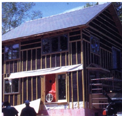
Le test d'infiltrométrie a révélé que la maison est très étanche.
