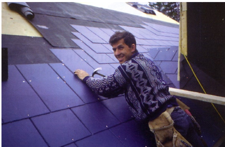
L'entrepreneur Dorcy Laroche a posé la tuile d'amiante-ciment. Très facile et sans poussières, avec des clous de cuivre et une tranche.
